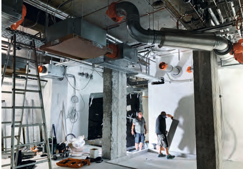
Universität Würzburg Sanierung Tierhaltung
