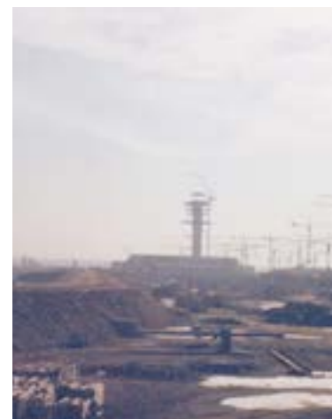
Bau des Flughafen München
