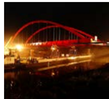
Verschiebung fertiger Brücke
