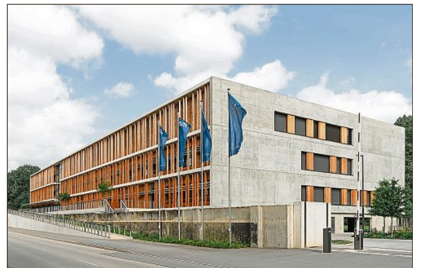
Der Neubau. Im Vordergrund das Zugangsbauwerk und die Hochwasserschutzwand (Bestand).
